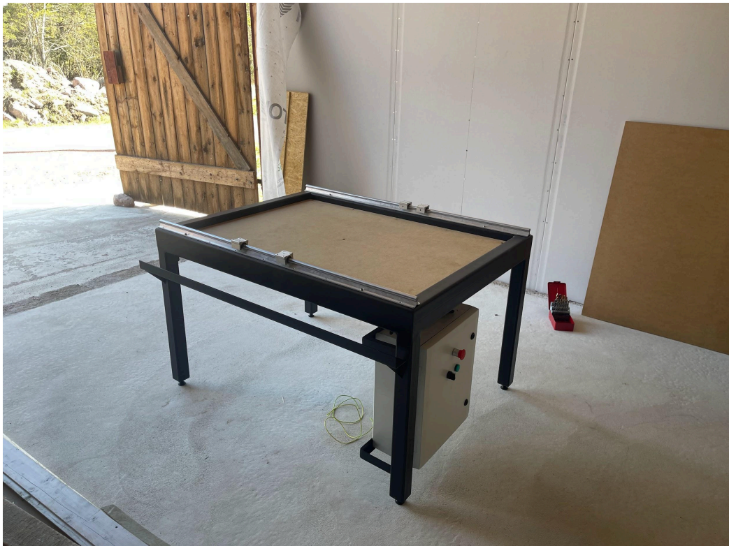
Figur 48. Påbörjad montering av fräsbordet.
