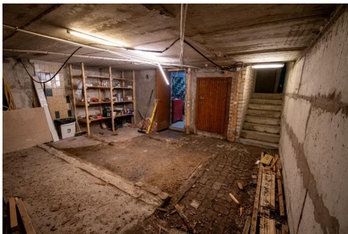
Kuva 14. Kellarikerroksen nykytilanne ja näkymä porraskäytävään.
