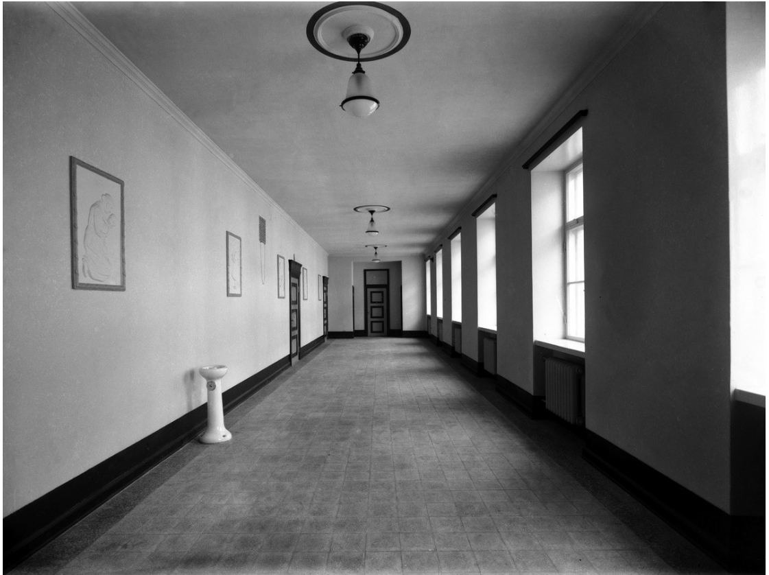
Kuva 5. 3 kerroksen käytävä vuonna 1926 (Sundström 1926)
