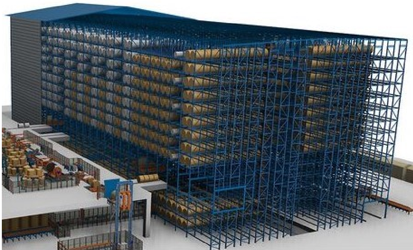
Kuva 1. Pesimal korkeavarastorakennus. (Pesimal, i.a.).
