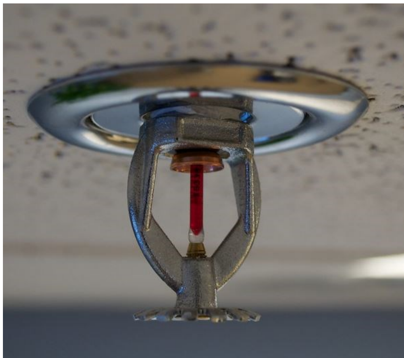
Kuva 3. Sprinklerisuutin (Leon, 2010).
