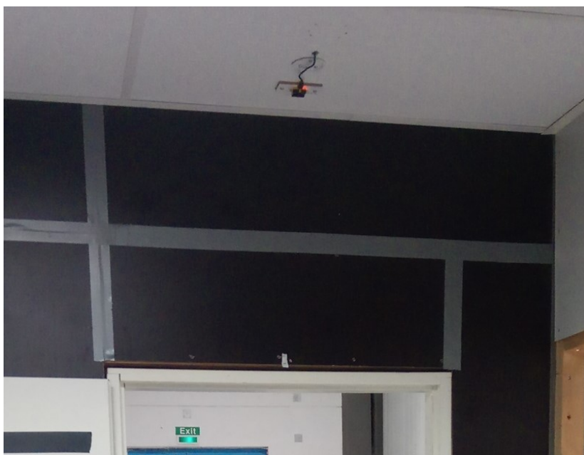
Kuva 8. Laskuri 5 testihuoneen alakatossa
