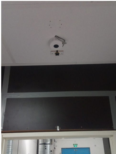
Kuva 7. Laskuri 4 ja 5 asennettuna oviaukon yläpuolelle
