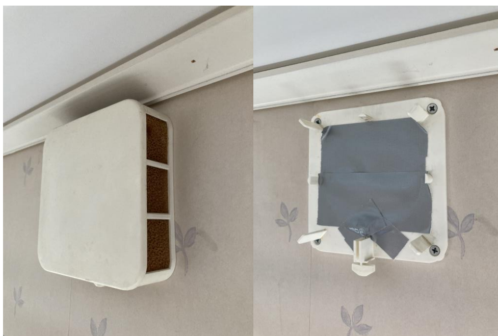
Kuva 9. Korvausilmaventtiili teipattu umpeen ilmastointiteipillä.
