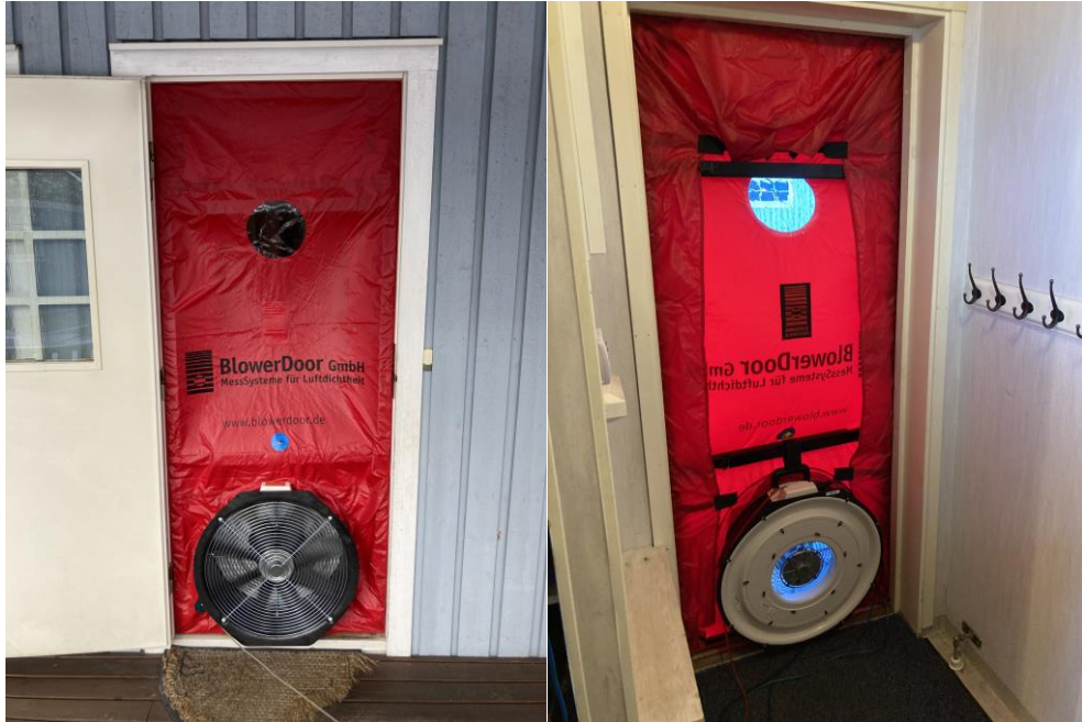
Kuva 11. Ovipuhallin asennettuna kohteeseen.
