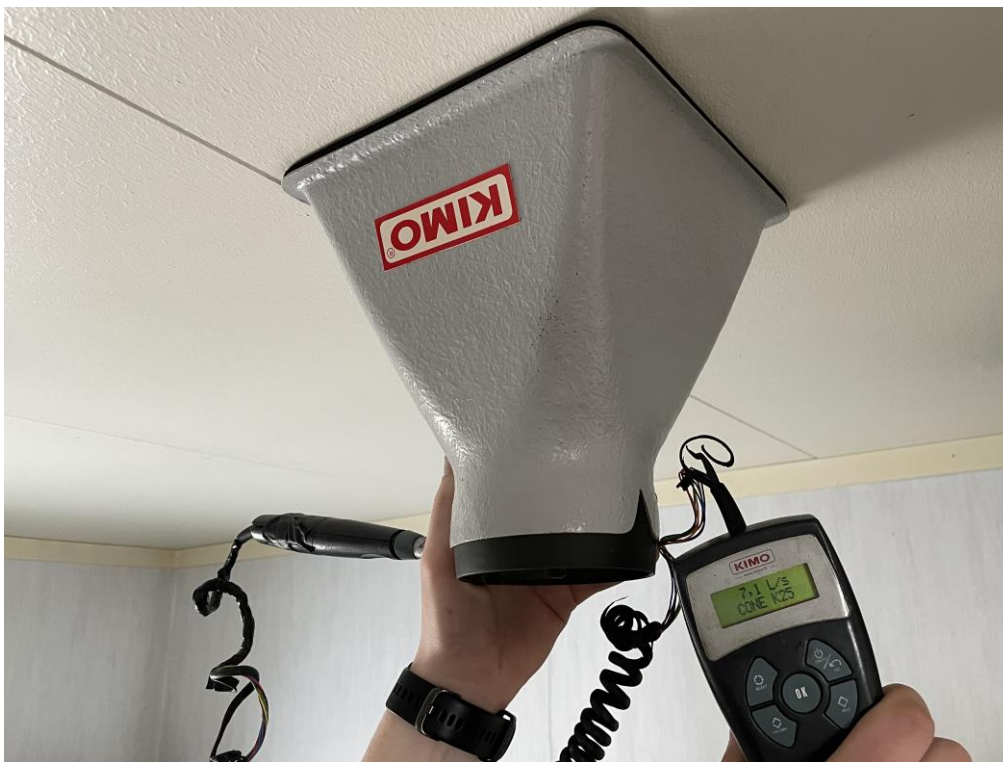
Kuva 17. Poistoilmamäärän mittaus kodinhoituhuoneen katosta.
