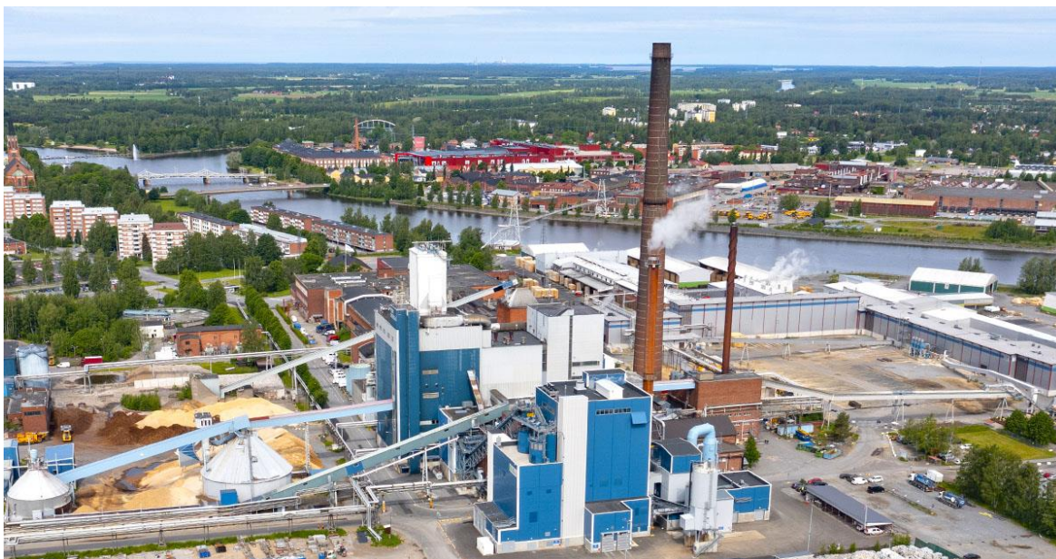
Kuva 1. Aittaluodon voimalaitos (Pori Energia Oy, 2024).
