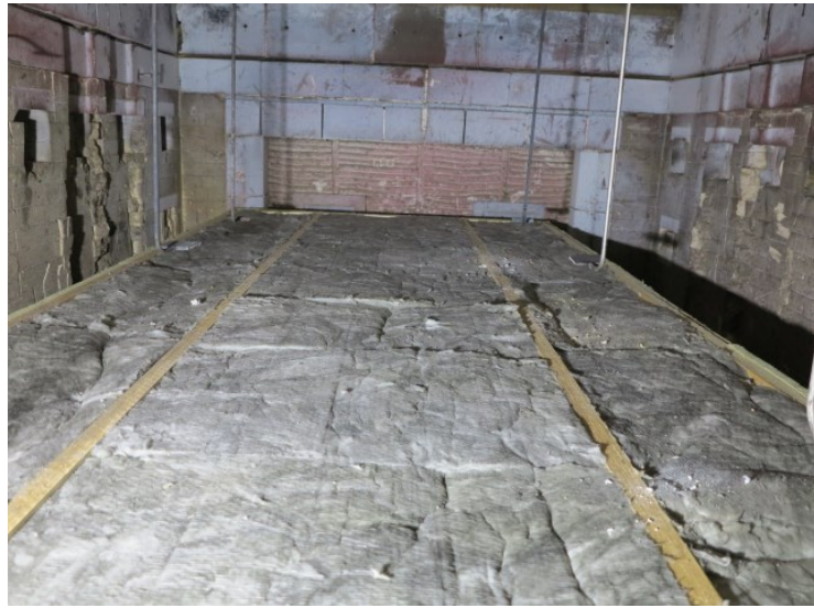
Kuva 17. Rakenne asennettu uuniin.
