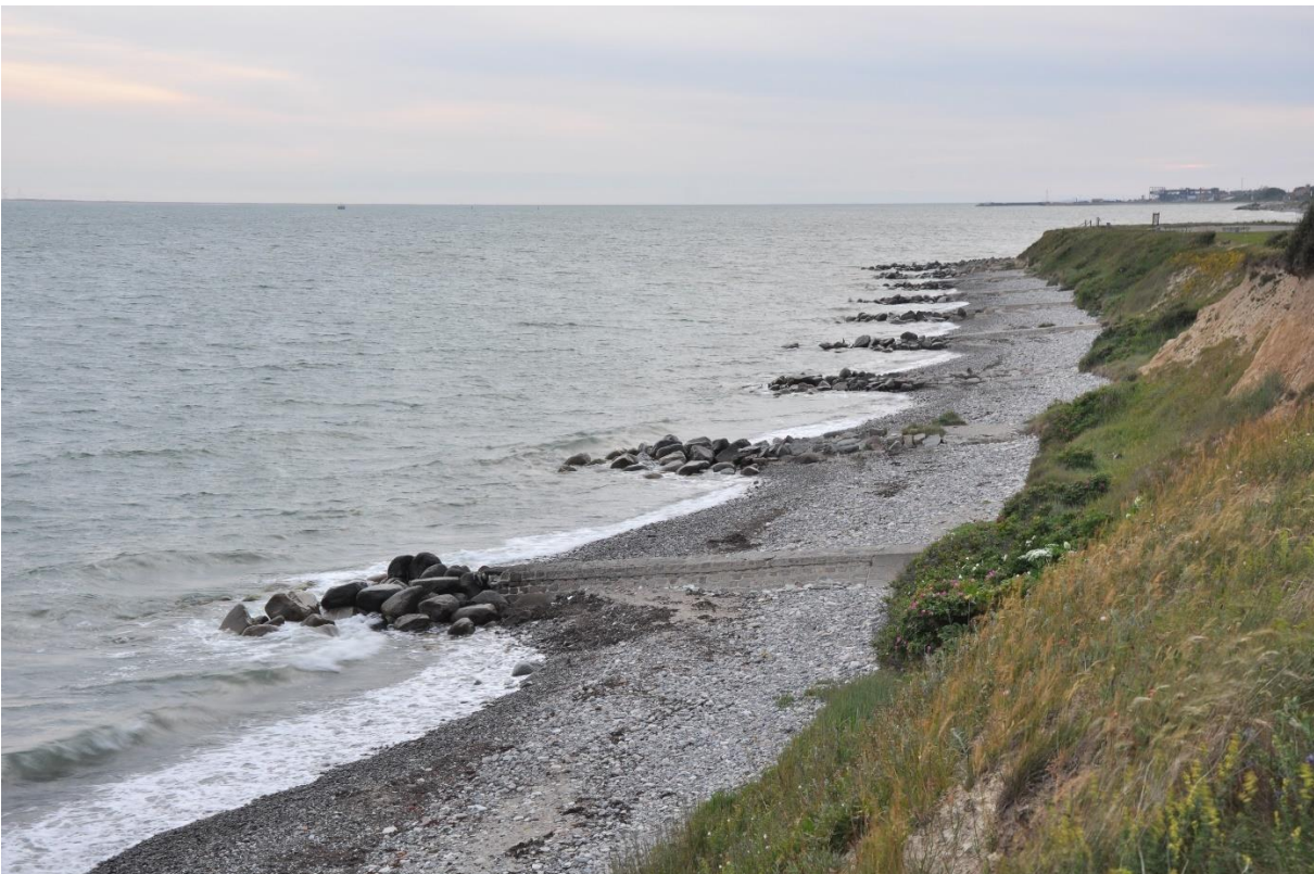
Kuvio 16: Rantajyrkäne ja suojarakenteita
