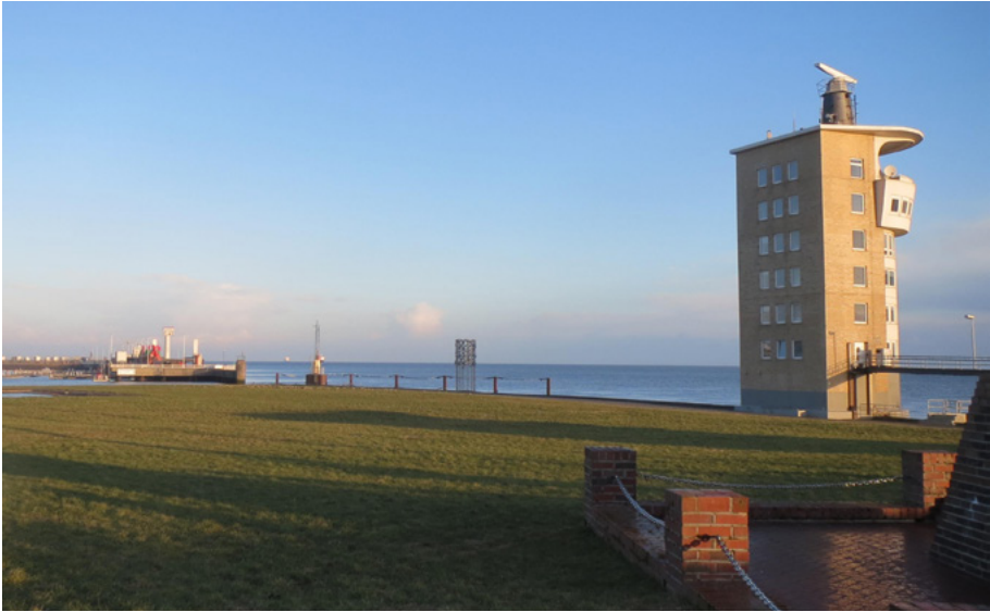
KUVA 28. Havariekommandon toimisto- ja kokoustilat sijaitsevat tutkatornissa Cuxhavenin satamassa (kuva: Raisa Kääriä).
