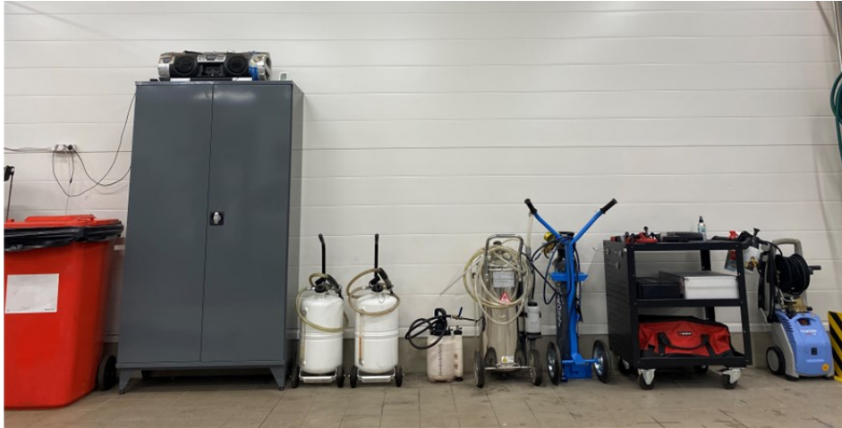
Kuva 5. Ulkoseinusta lajittelun jälkeen.
