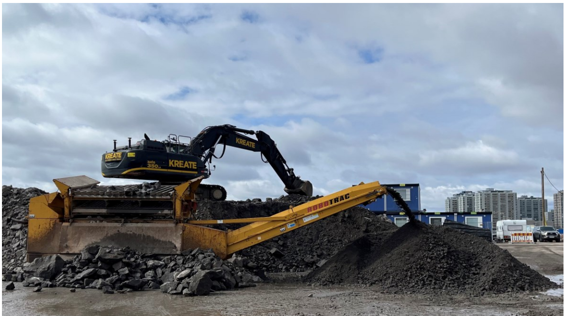
Kuva 6. Maa-aineksen täryvälppäämistä, jotta maa-aines saadaan uusiokäytettyä työmaalla.
