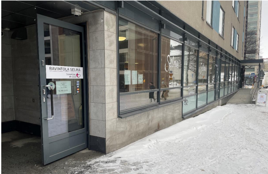
Kuva 10. Ravintola Selman julkisivu
