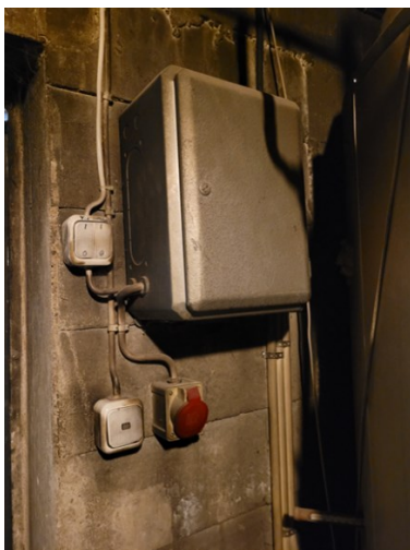
Kuva 3. Lämmönjakohuoneen jakokaappi
