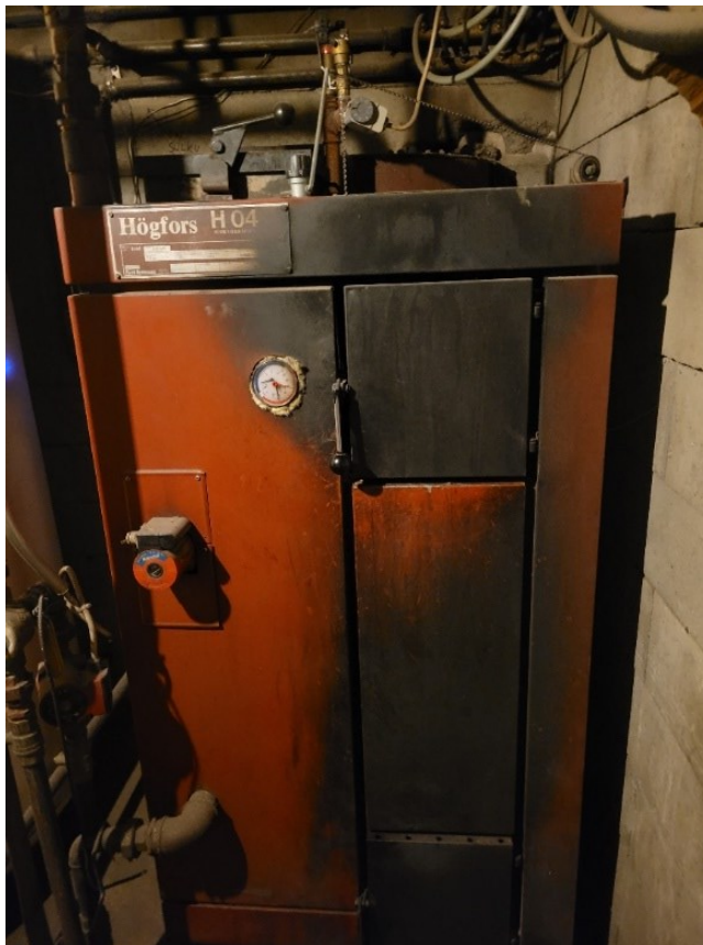
Kuva 1. Högfors H04 -puulämmityskattila
