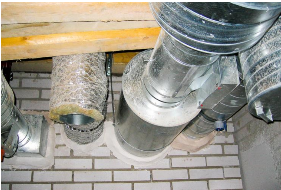
Kuva 9. Ilmanvaihtokanavan läpivienti tiiliseinästä [15].
