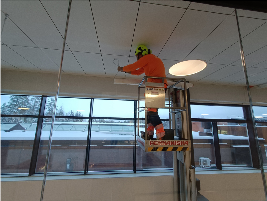
Kuva 24. Paneelin asennus kattoon
