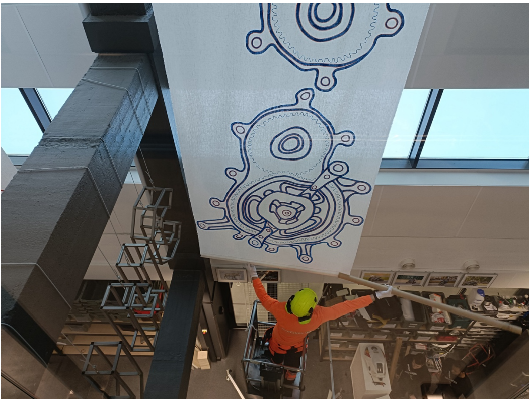
Kuva 25. Paneelin rullaus pahviputkelta
