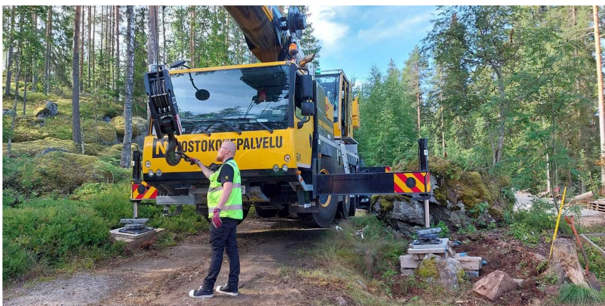
KUVA 4. Nosturi paikallaan rakennusten nostoa varten (Miettinen 2022)
