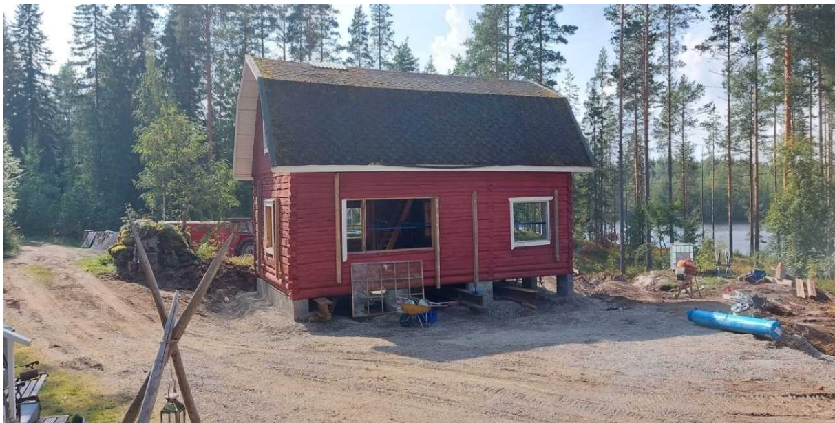
KUVA 15. Hirsimökki siirrettyä uusille perustuksille (Miettinen 2022)
