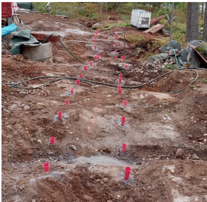
KUVA 16. Viemärointi kanaalin panostus (Miettinen 2022)
