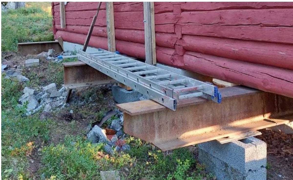
KUVA 8. Nostopalkit asennettuina ja tuettuina mökin alle nostoa varten (Miettinen 2022)
