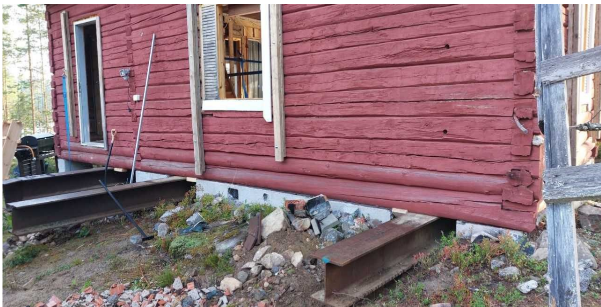
KUVA 10. Sivuseinää tukevat lankut (Miettinen 2022)
