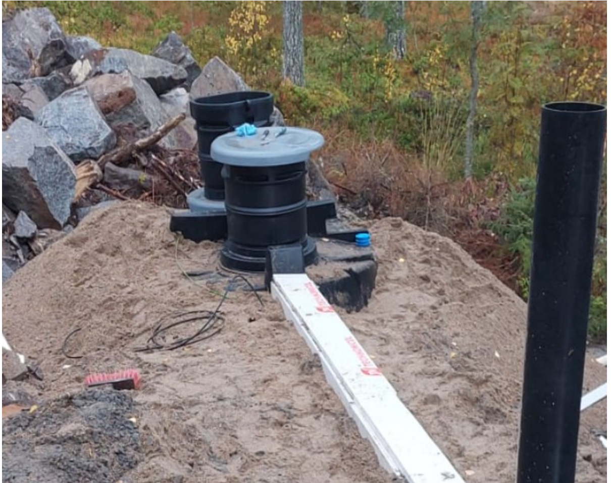
KUVA 17. Uponor Clean 1 panospuhdistamo asennettuna monttuun (Miettinen 2022)
