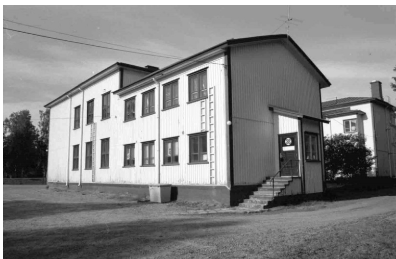
Kuva 2. Kannuksen monitoimitalo 1980-luvulla, (pvm. ei tiedossa, kuvaaja tuntematon).
