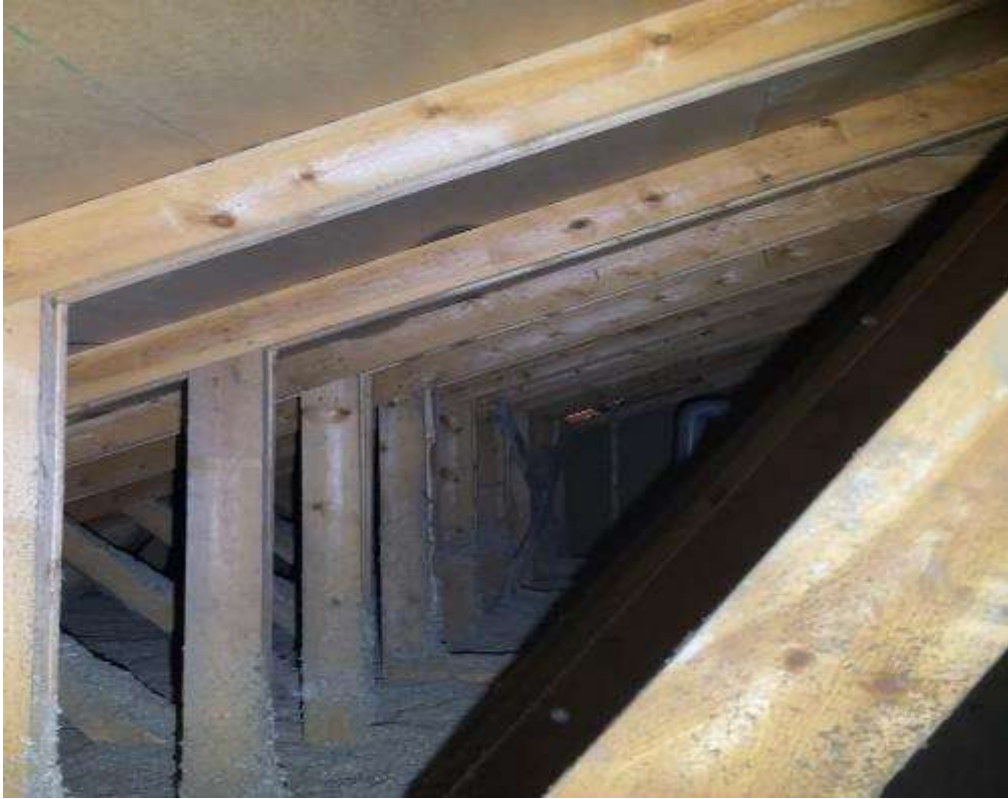
Kuvio 18. Kattotuoleja ja yläpohjaa
