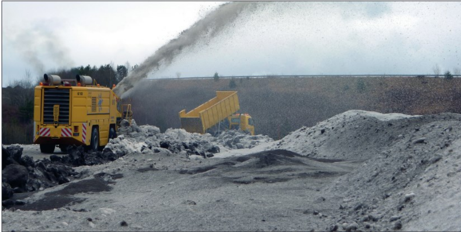
KUVA 13. Oslon lentokentän lumivarastoa täytetään lumitykeillä (Avinor/Halvard Felde)
