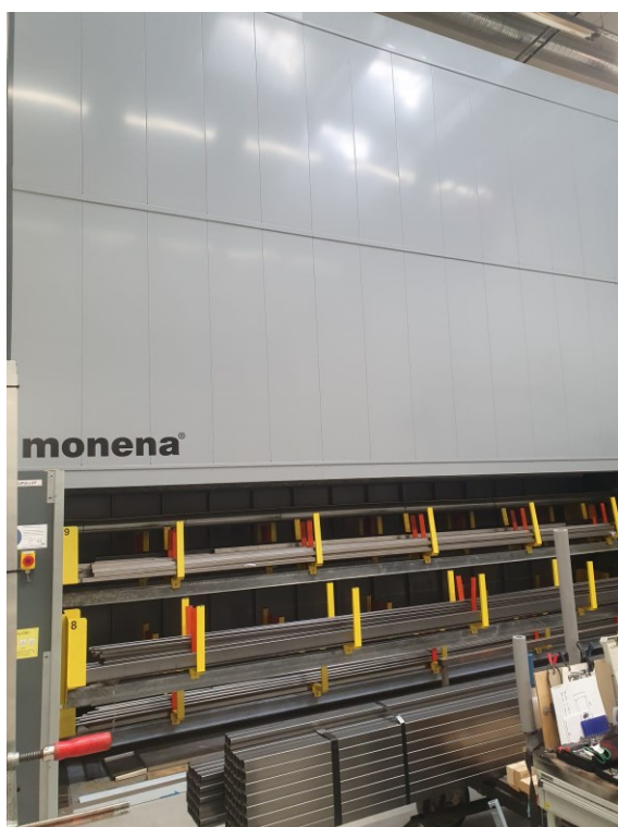
Kuva 7. Varastoautomaatti, jossa säilötään metallikankia.
