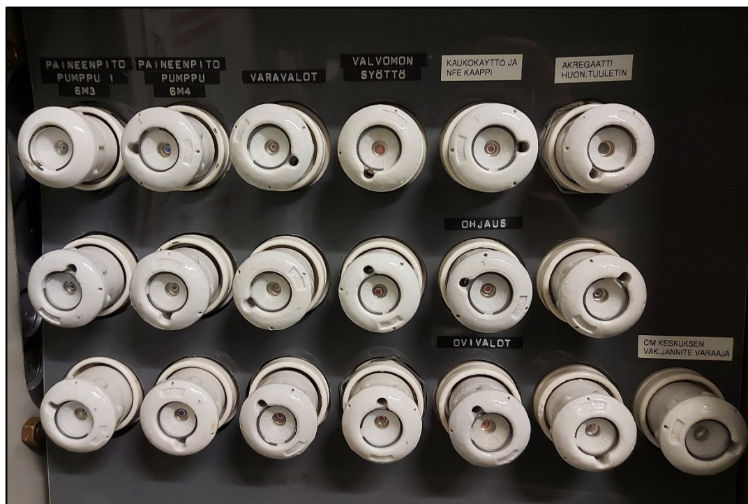
Kuva 16. EA-keskuksen sulakkeita.
