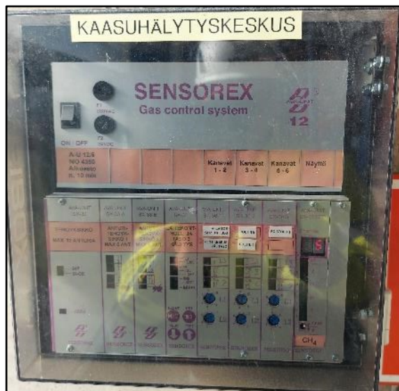
Kuva 26. Kaasuhälytyslaitteisto.
