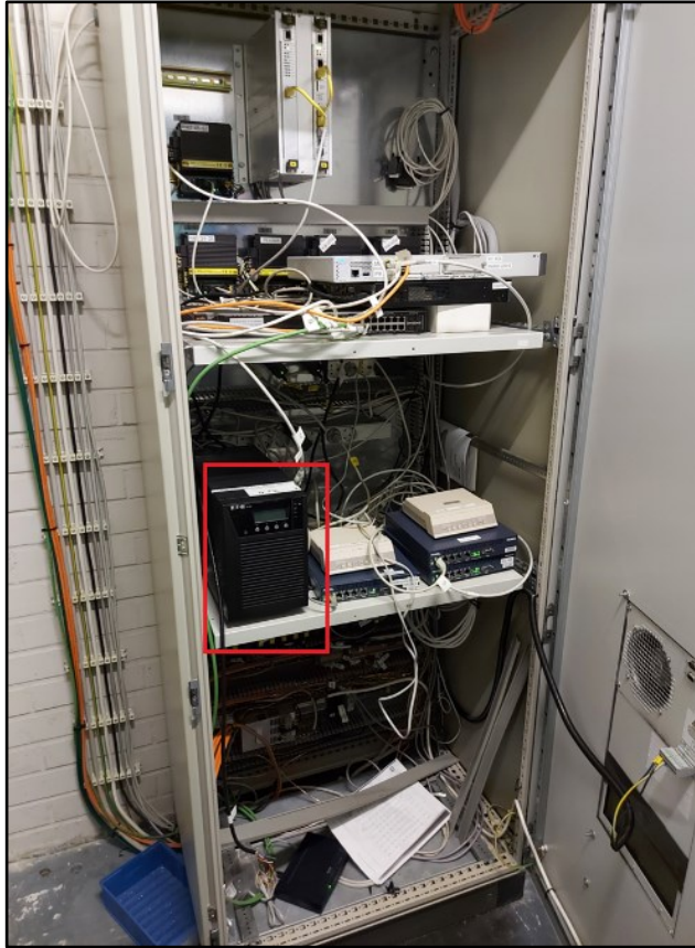
Kuva 21. SCADA-kaukokäyttökaappi.
