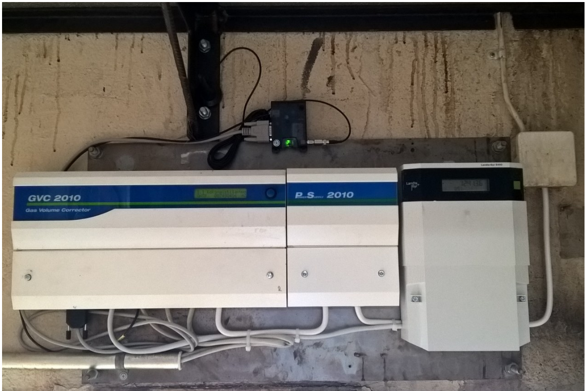
Kuva 22. GVC-2010-kaasumäärämuunnin, virtalähde, modeemi ja etäluentapäätte.
