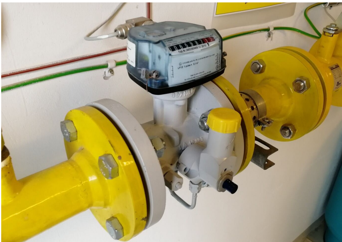
Kuva 19. Kaasumäärämittari, jossa kiinni laskuri.
