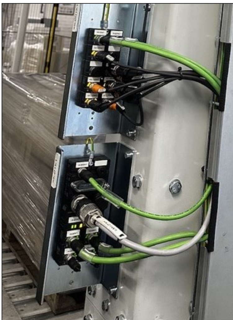
KUVA 6. Cube67 -SIO-, ja – PROFINET IO Gateway -moduulit (Kuva: Matias Blomqvist).
