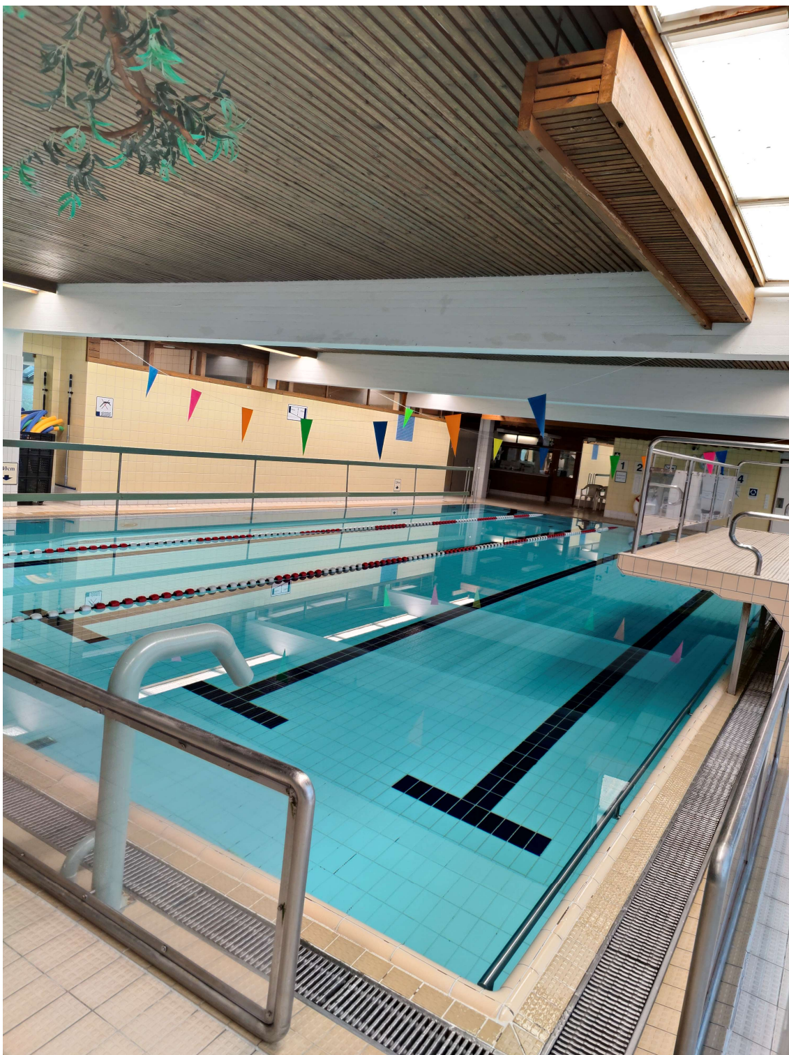
Kuva 5. Nykyinen pääallas (Hakala 2023)
