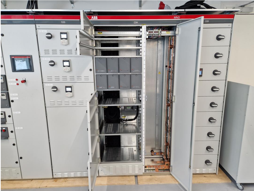
KUVA 21. MNS Digital -keskuksen varausosa.
