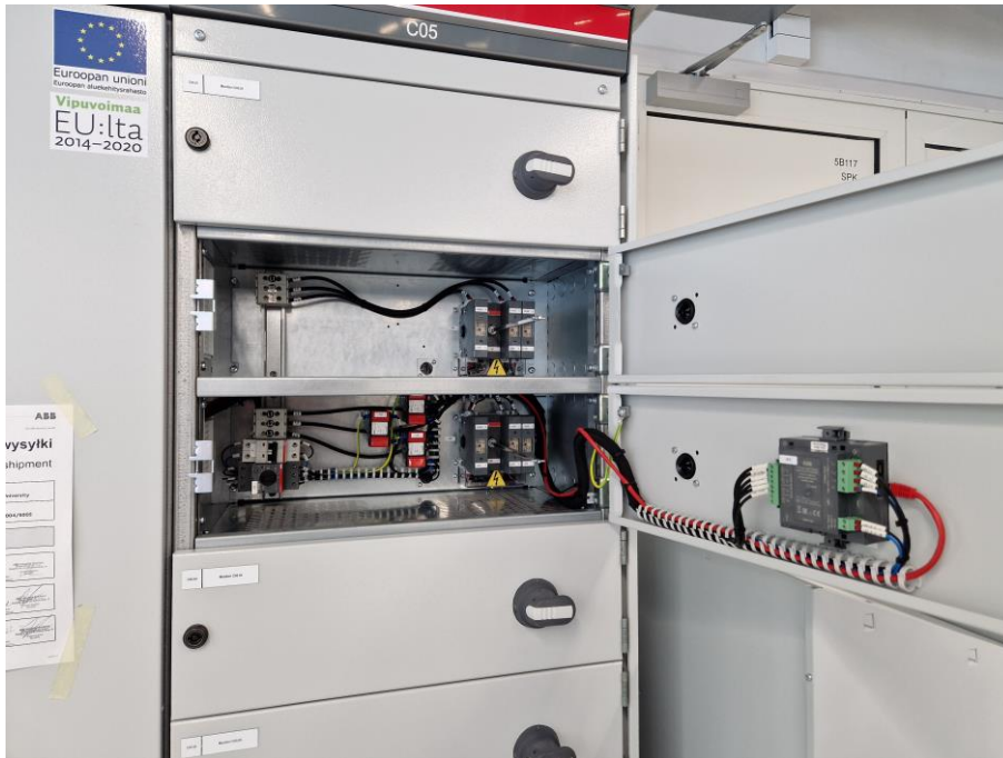
KUVA 14. ABB MNS Digital -keskuksen varokelähtöjä.
