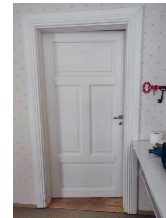
Befintlig trädörr och dörrfoder
