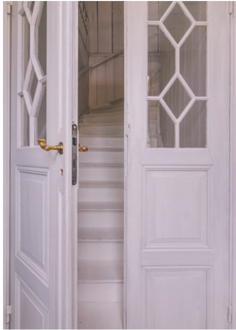
Figur 9. Vanlig dörr mellan kök och hall på 1920-talet.
