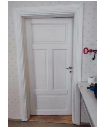
Befintlig trädörr och dörrfoder
