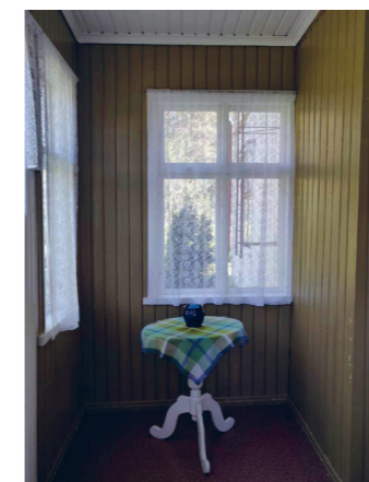
Befintliga fönster, fönsterfoder, tak, tak- och golvlister
