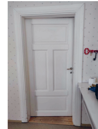
Befintlig dörr och dörrfoder
