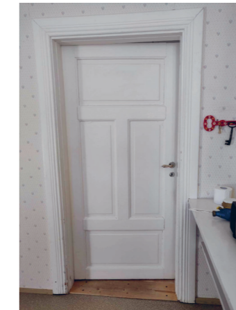
Befintlig trädörr och dörrfoder
