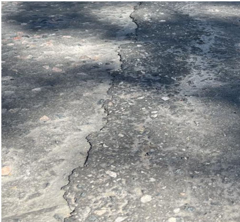
Kuva 13 Kylmänä tehty sauma, Riku Jansson 2023
