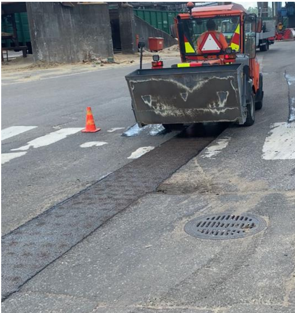
Kuva 8 Konetiivistetty valuasfalttipaikka, Riku Jansson 2023
