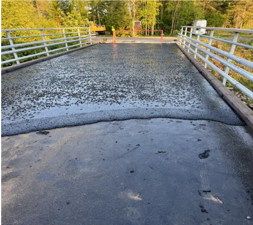
Kuva 6 Valuasfaltti levitetty mastiksin päälle puukantisella sillalla, Riku Jansson 2023
