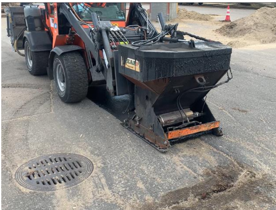
Kuva 7 Konetiivistetty valuasfalttipaikka, Riku Jansson 2023
