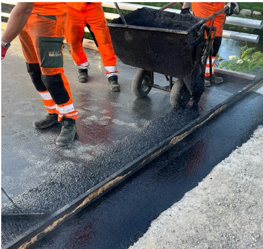
Kuva 1 Kolamies kolaa valuasfalttia, Riku Jansson 2023
