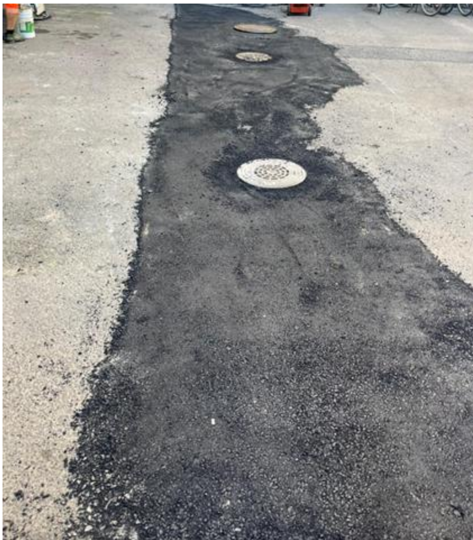
Kuva 11 Pohjat tasoitettu asfaltticonilla ennen valuasfaltin valamista, Riku Jansson 2023
