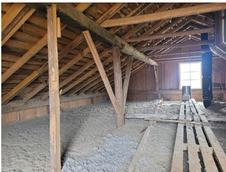
KUVA 9. Tuulettuva yläpohja uudella eristeellä (Kuva: Aapo Saksa)
