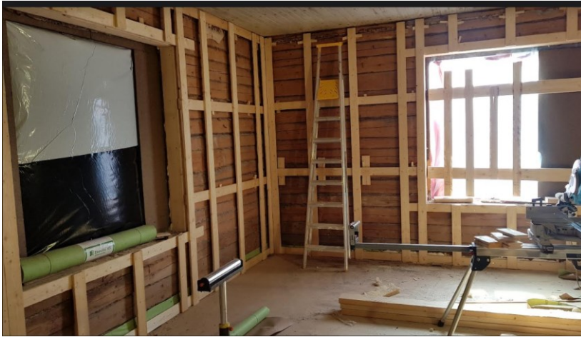
KUVA 7. sisäseinien lautakoolaus (Kuva: Aapo Saksa)
