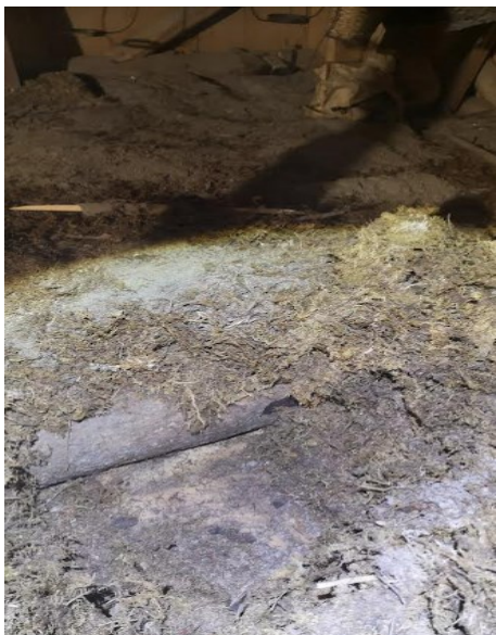
KUVA 8. Poistetut yläpohjaeristykset (Kuva: Aapo Saksa)
