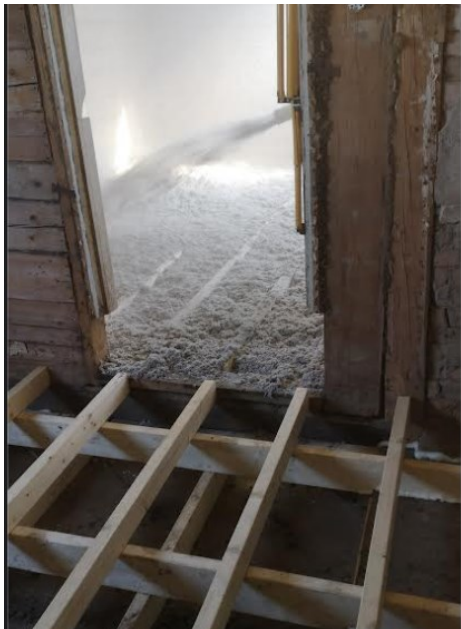
KUVA 10. Uusi alapohja (Kuva: Aapo Saksa)
