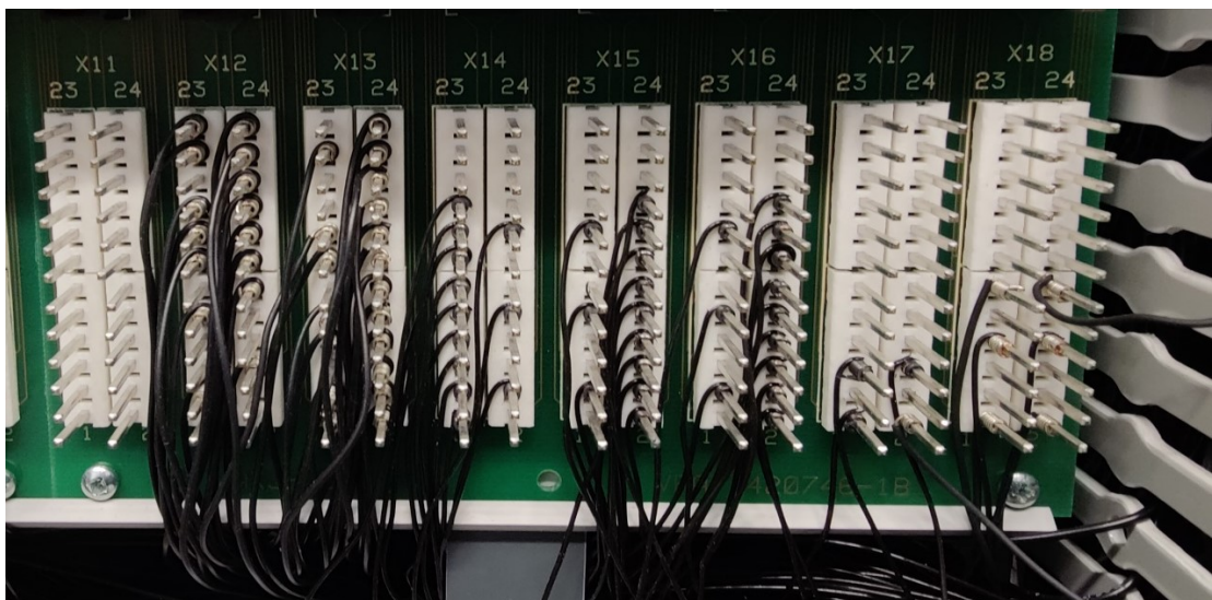
Kuva 23. AXJ-liittimien pinnien ”räppäykset” (Hirvonen 2022)
