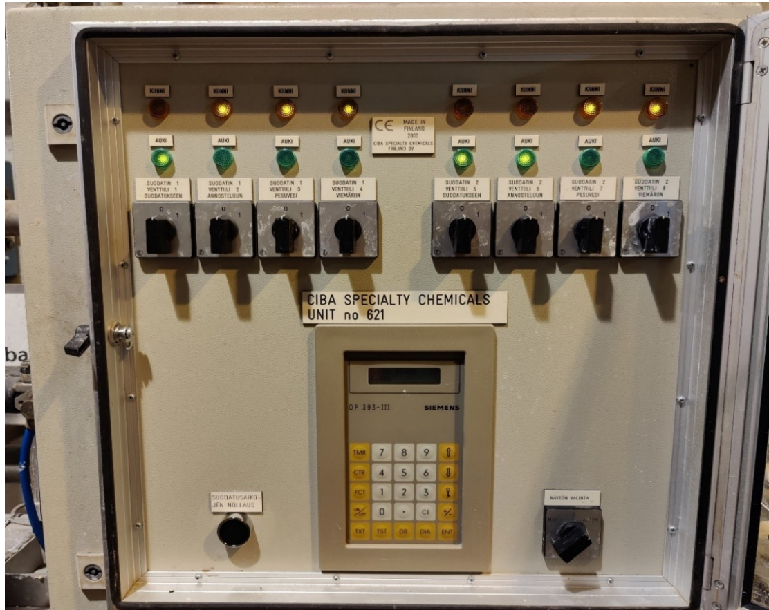
Kuva 7. Bentoniittisuotimen vanha paikallisohjaukskotelo (Hirvonen 2022)
