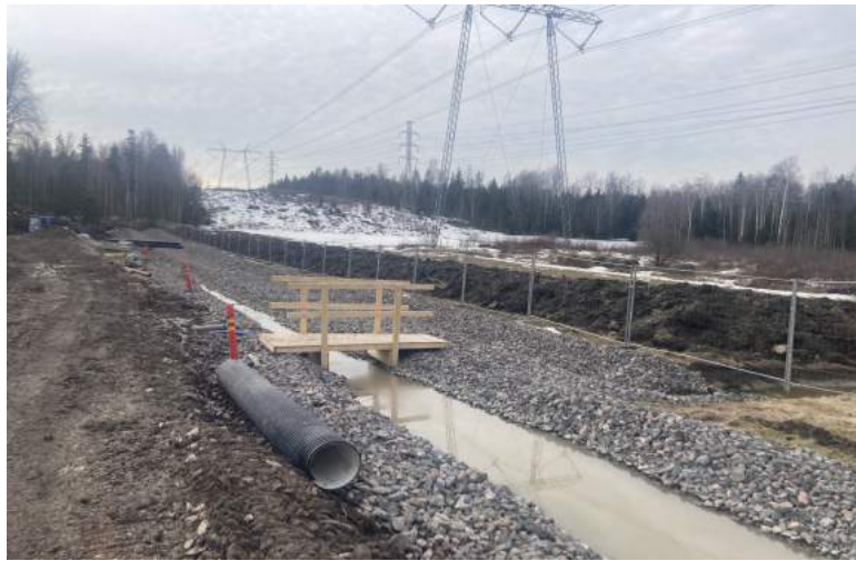
Kuva 1 Sepelillä eroosiosuojattu työmaaaja
