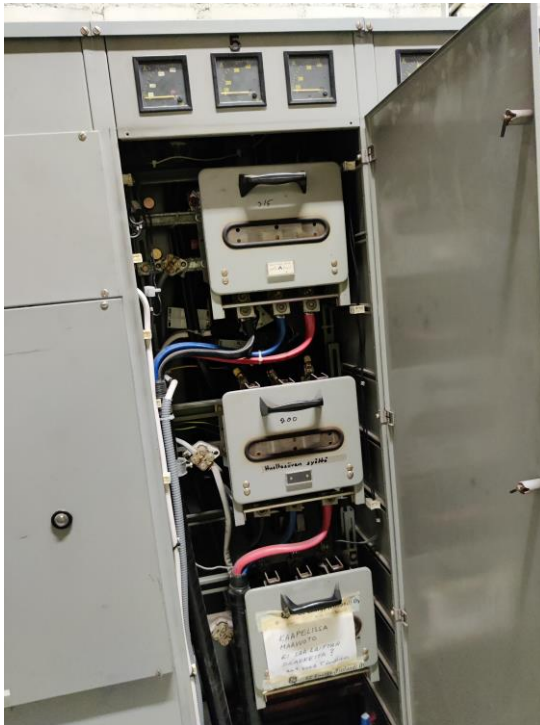
Kuva 21. ”Uuninluukku”-varokekytkin
