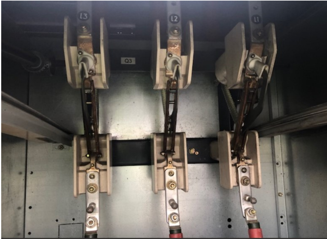
Kuvio 19. Kuormaerotin ABB mallia NAL 24
