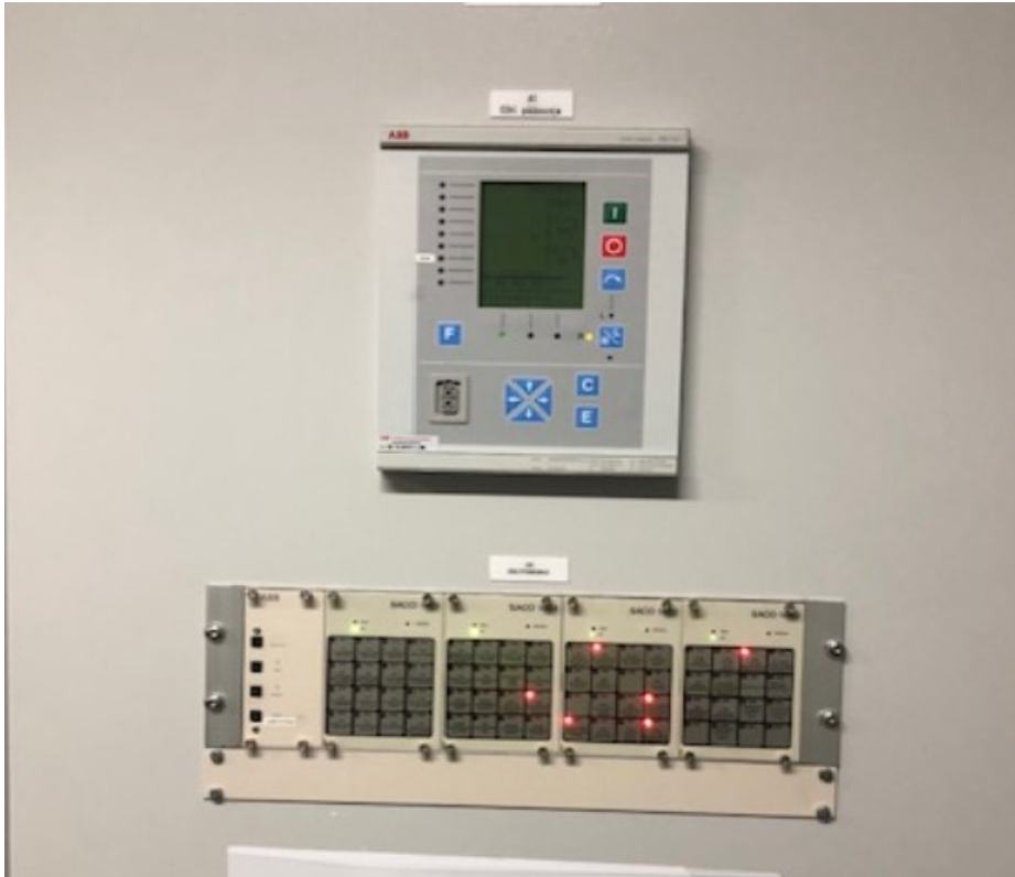
Kuvio 23. SJ -kentän kennotermiini ja SACO -hälytyskeskus
