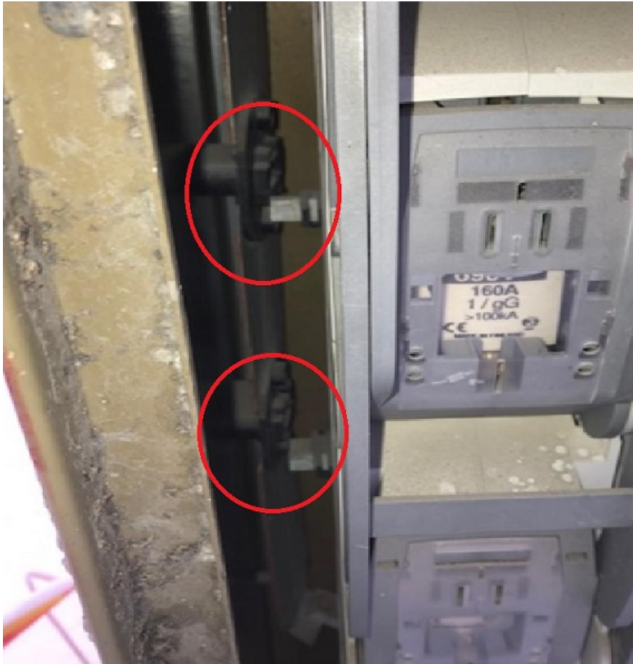
Kuvio 38. Kuviossa ABB MJS -tyypin katujakokaapista, missä kiskot ovat irronneet eristimiltä
