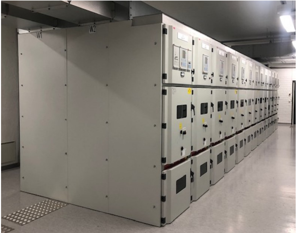
Kuvio 14. ABB UniGear -kojeisto
