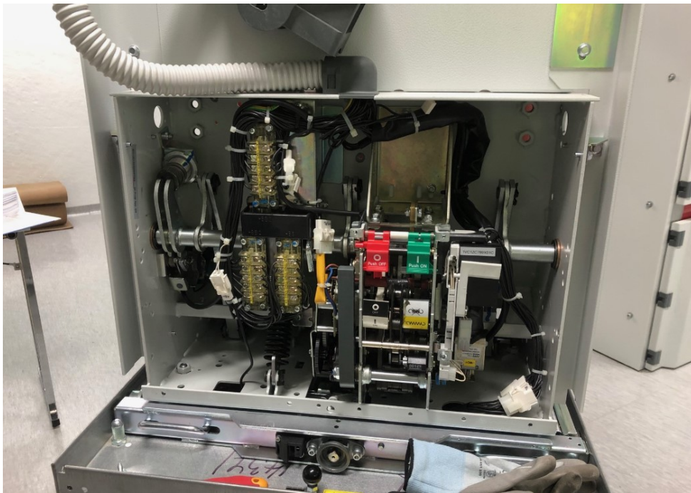
Kuvio 25. VD 4 -tyhjiökatkaisija etulevy poistettuna huollossa
