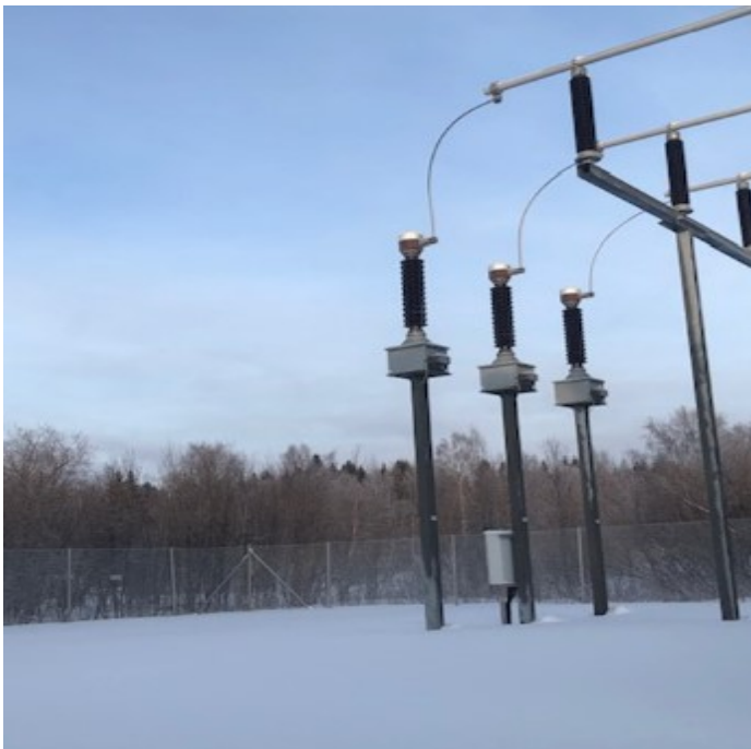
Kuvio 7. Kuvassa putkikiskoon kytketyt Artech UTD-123 -jännitemuuntajat
