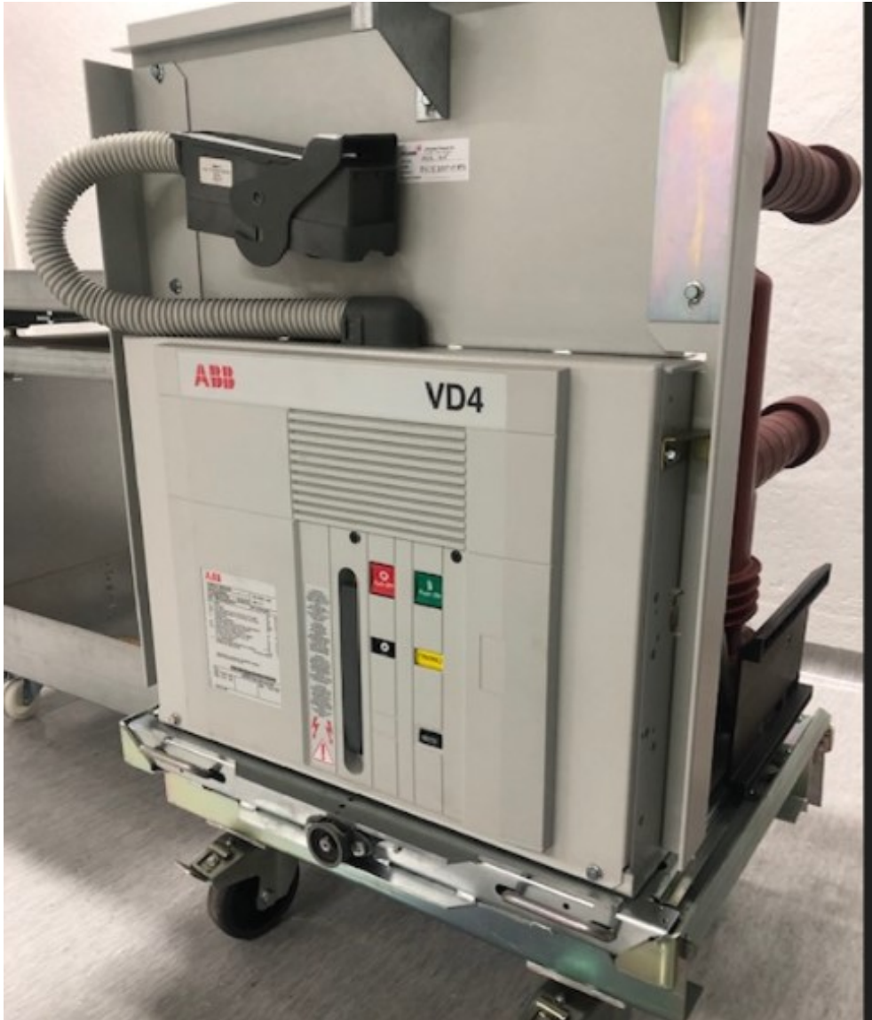
Kuvio 12. ABB:n tyhjiökatkaisija malliltaan VD 4 edestäpäin
