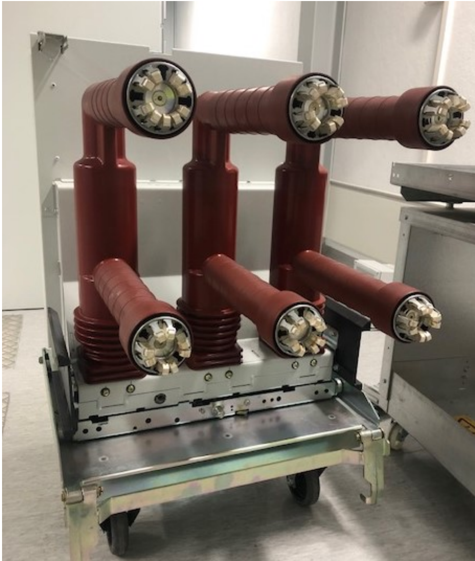
Kuvio 13. ABB:n tyhjiökatkaisija malliltaan VD 4 takaapäin
