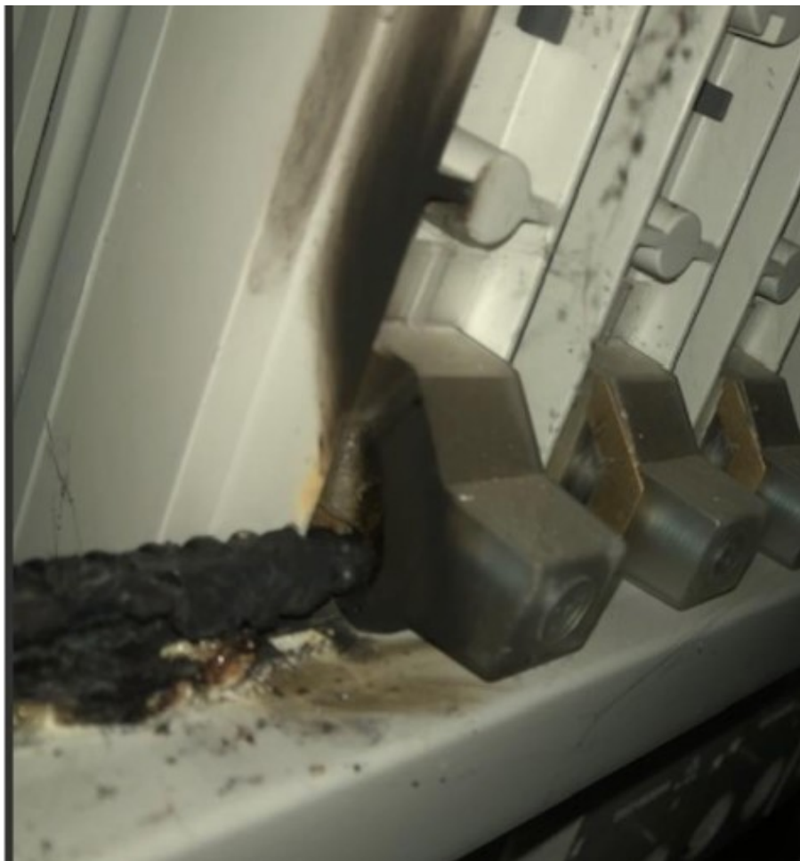
Kuvio 40. Löysän liitoksen sulattamat kosketinsuojat
