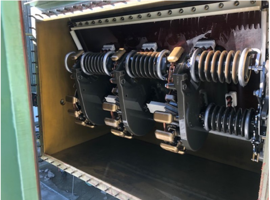
Kuvio 24. Tehomuuntajan käämikytkimen kansi avattuna huollon yhteydessä
