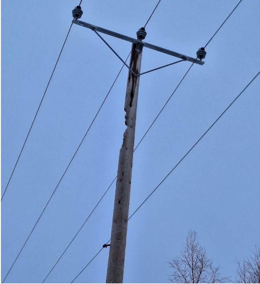
Kuvio 30. SD 37 -eristimellä varustettu taso-orisi
