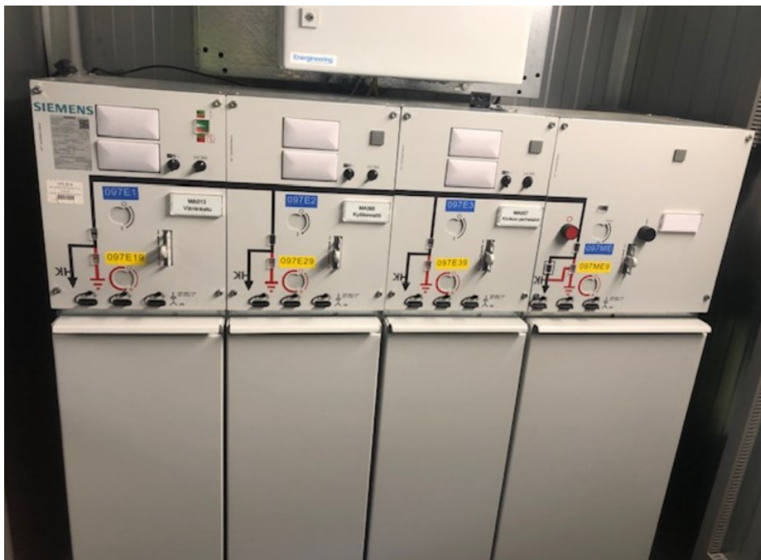
Kuvio 20. Siemens SF 6 -kaasulla eristetty keskijännitekojeisto
