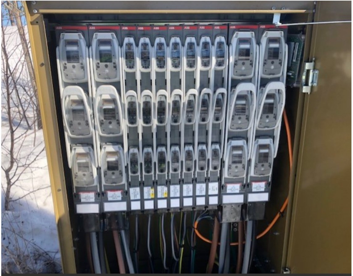
Kuvio 22. ABB:n valmistama katujakokaappi tyypiltään MJS
