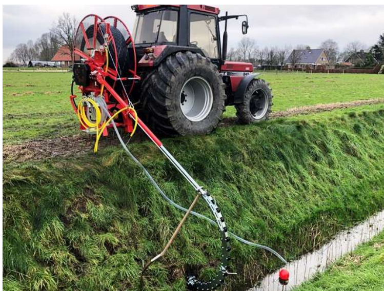
KUVA 6. Salaojan huuhtelua Homburg Blizz-salaojahuuhtelulaitteella (Ab Tomas Kjellman julkaisuaika tuntematon)
