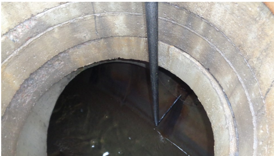
Kuva 11. Vesijuoksun mittaus kaivokulmalla.
