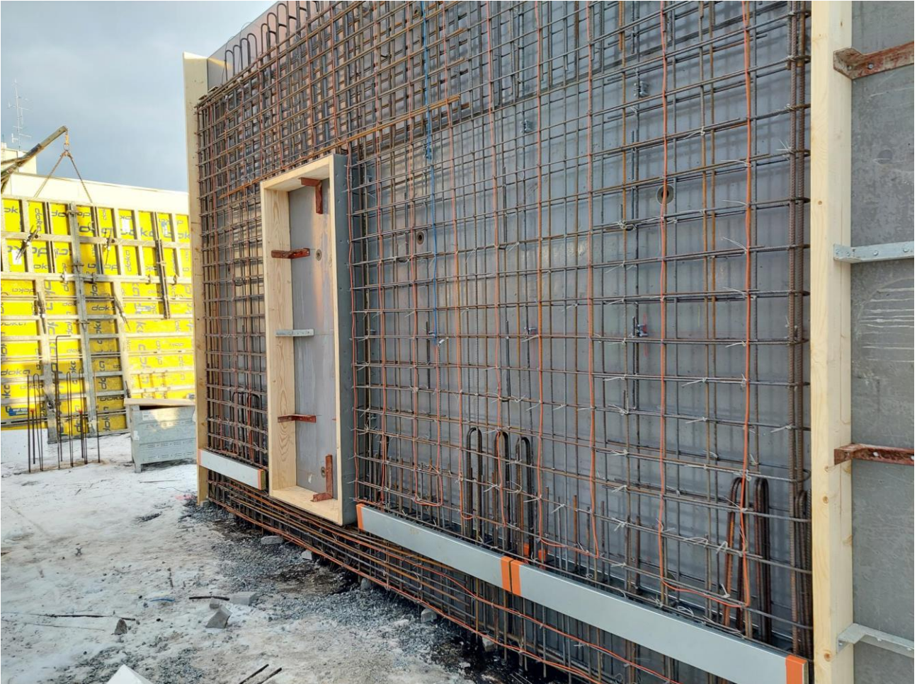
Kuva 2. Seinämuotti raudoitettuna. (Leppinen, 2023, CC BY-NC-ND)
