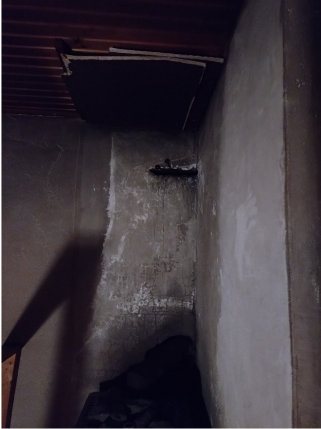
KUVA 16. Seinää ja kattoa saunan kiukaan yläpuolella
