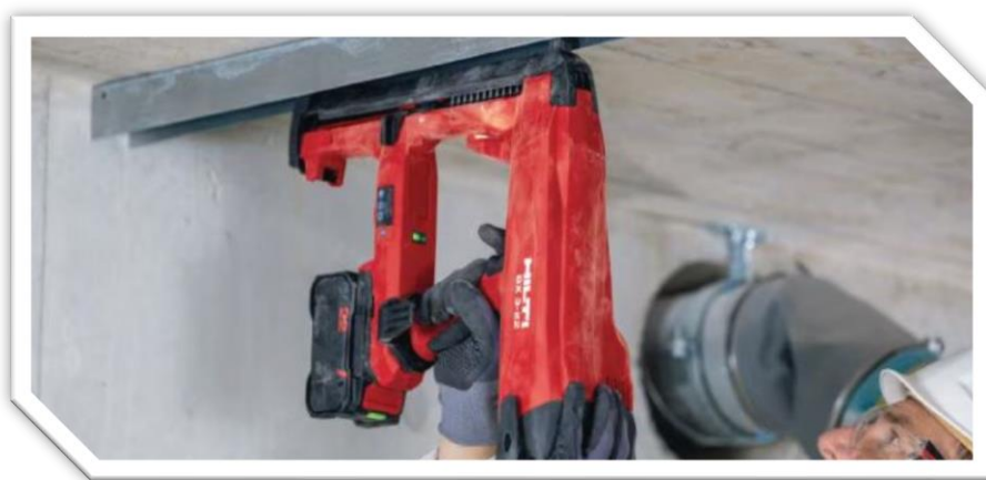
Kuva 14. Yläpään kiskon kiinnitys käyttäen Hilti BX3 akkurankanaulainta. (Hilti Finland).
