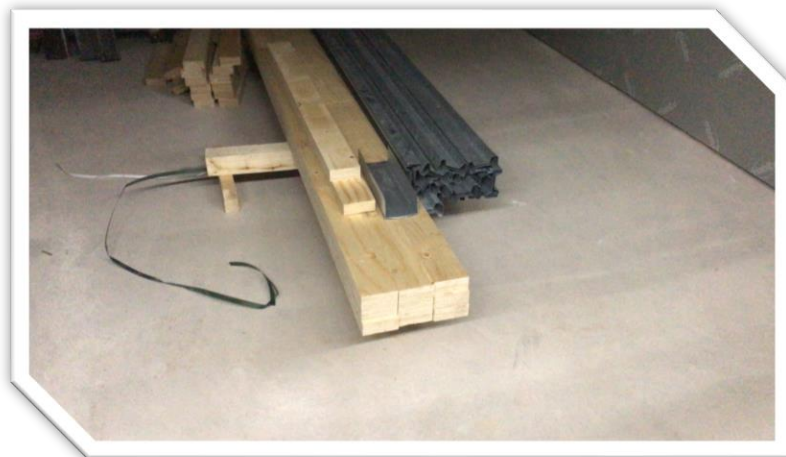
Kuva 6. Työmaalle toimitettua Gypsteel XR teräsrankaa ja lvi-tolppia (kuva otettu maaliskuussa 2024).
