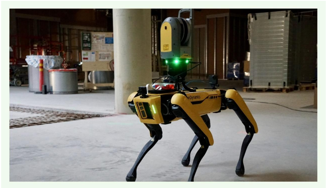
Kuva 2. Yhdysvaltalaisen Boston Dynamics:n kehittämä robottikoira Spot kerää pistepilvitietoa työmaan 3D-tietomalliin. Kuva: AE Partners.
