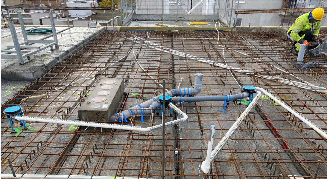
Kuva 10. Kuorilaatan raudoitus-, sähkö- ja viemärintityöt
