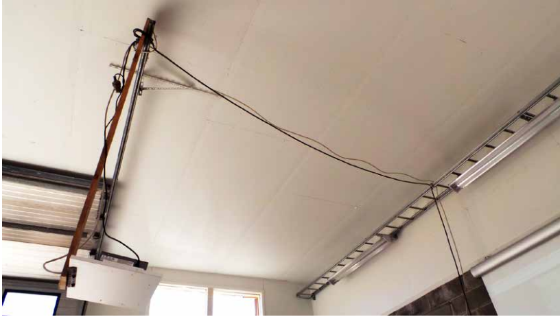
KUVA 31. Datatykkiä varten rakennettiin konehallin teline.
