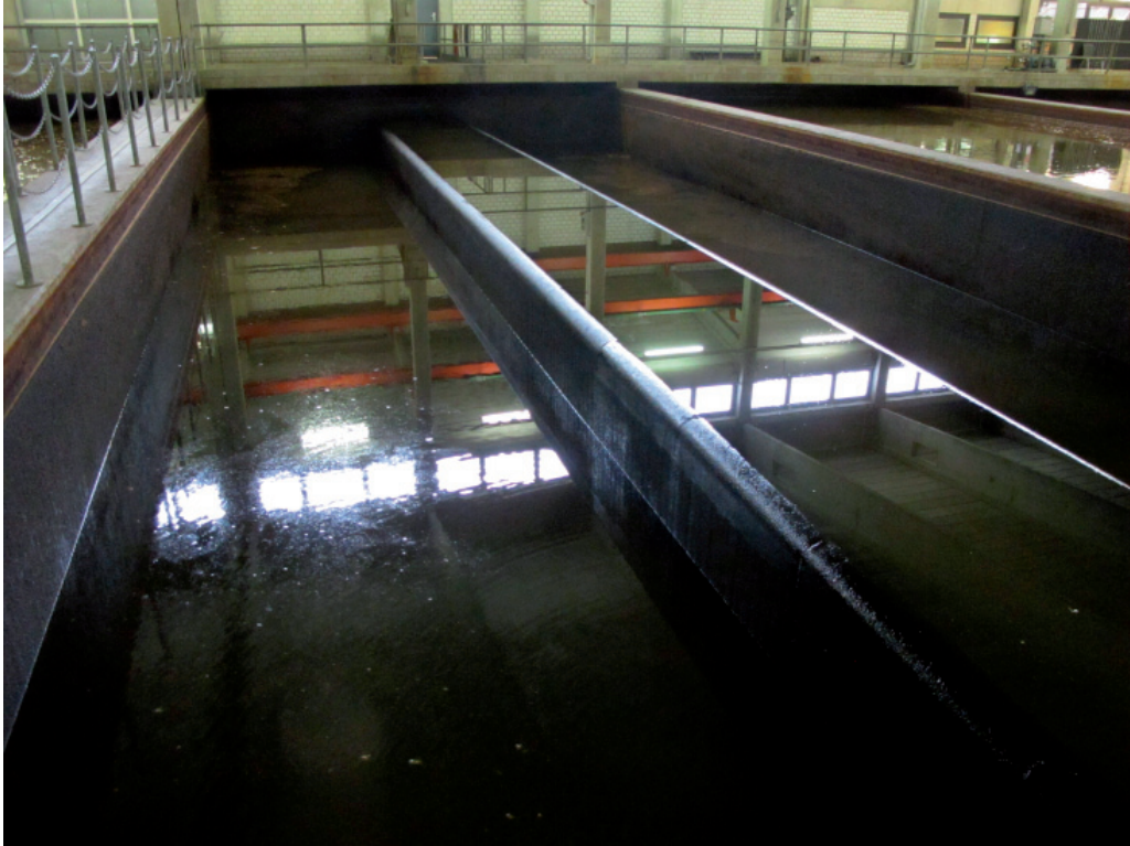
KUVA 4A, 4B & 4C. Wahnbach-Verbandin fosforinpoistolaitoksen prosessi on yksikertainen. Veteen sekoitetaan saostuskemikaali, jonka jälkeen orgaanisen aineksen ja fosforin saostuminen alkaa selkeytyskanaalissa. Saostuvia flokkeja vahvistetaan polymeerillä ja ne suodatetaan vedestä pikahiekkasuodattimessa. (Kuvat: Juha Kääriä)
