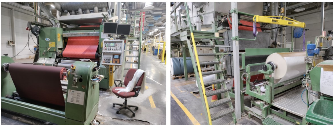
Figur 35. Avrullning (vänster) och ihoprullning (höger) vid PSA-anläggningen.
