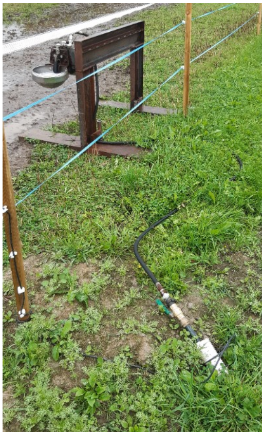
KUVA 11. Eräs painevedellä toimiva juottopaikka, jossa navetasta tuleva vesijohtoputki on eristetty styroksilla ja kaivettu maan alle kulkureitin vuoksi (Huttunen 2022f).
