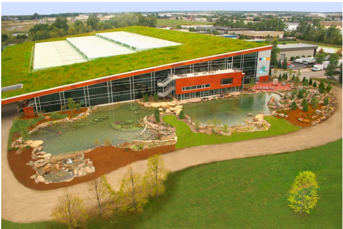
Kuva 86. Katto ennen romahdusta. Katto oli rakennettu vain 6 vuotta aiemmin [179]. Kuvasta arvioituna katon kaltevuus on noin 1:10 tai hieman loivempi. Romahtanut osa on ulkoneva lippa kuvan vasemmassa reunassa, jonka alla oli parkkitilaa.
