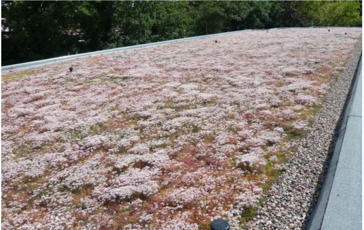
Kuva 1. Sedum isona pinta-alana, ekstensiivinen viherrakenne. Kaukasianmaksaruoho ( sedum spurium ) on punainen lajike, joka viihtyy karuissakin olosuhteissa.
