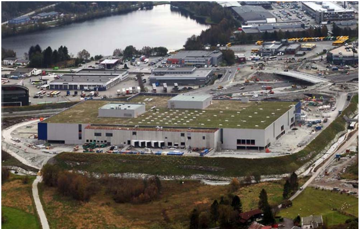
Kuva 83. Ikea Åsanen sedumkatto.
