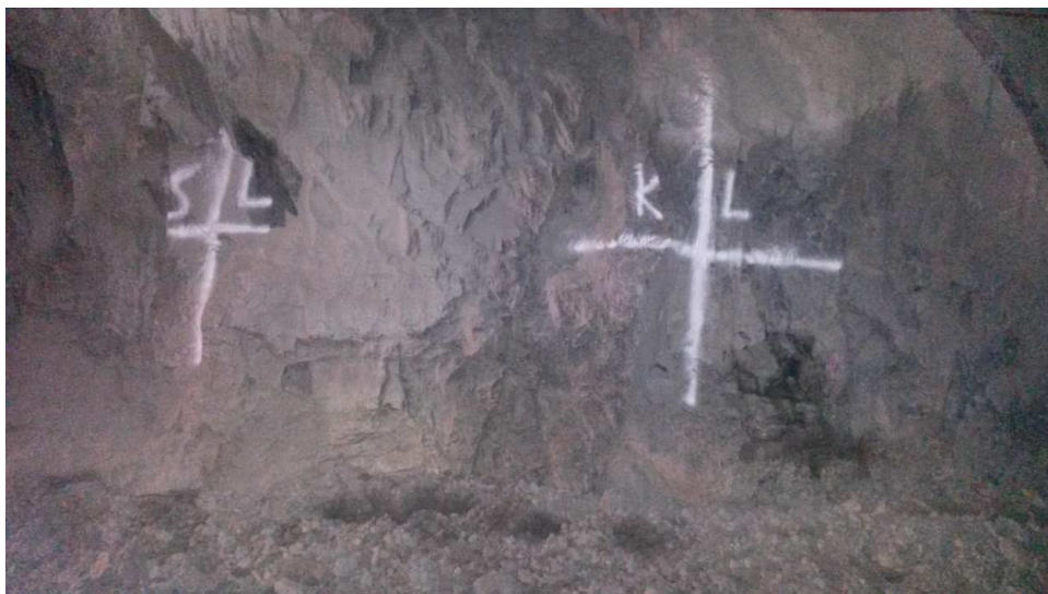
Kuvio 5. Peränajon tyypilliset porausmerkinnät.
