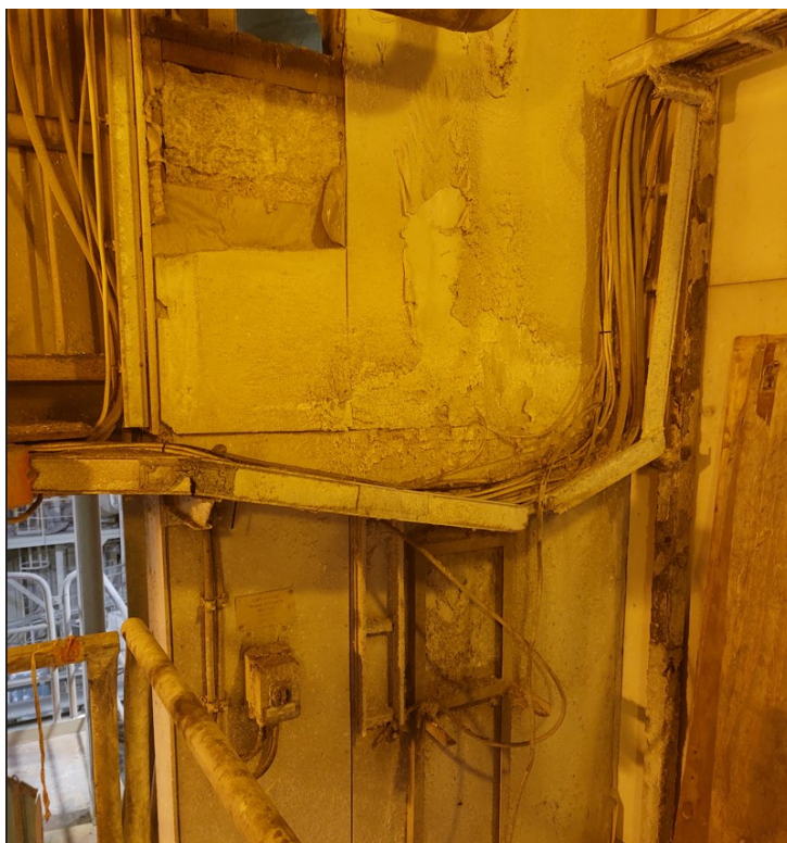
KUVA 7. Kaapelihylly FS460 suotimen vieressä (Tissari, Tuomas 2023)
