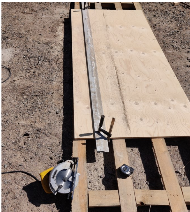
Kuva 14. Levyn sahaus työmaaolosuhteissa on helppoa (Pauli Parkkima)
