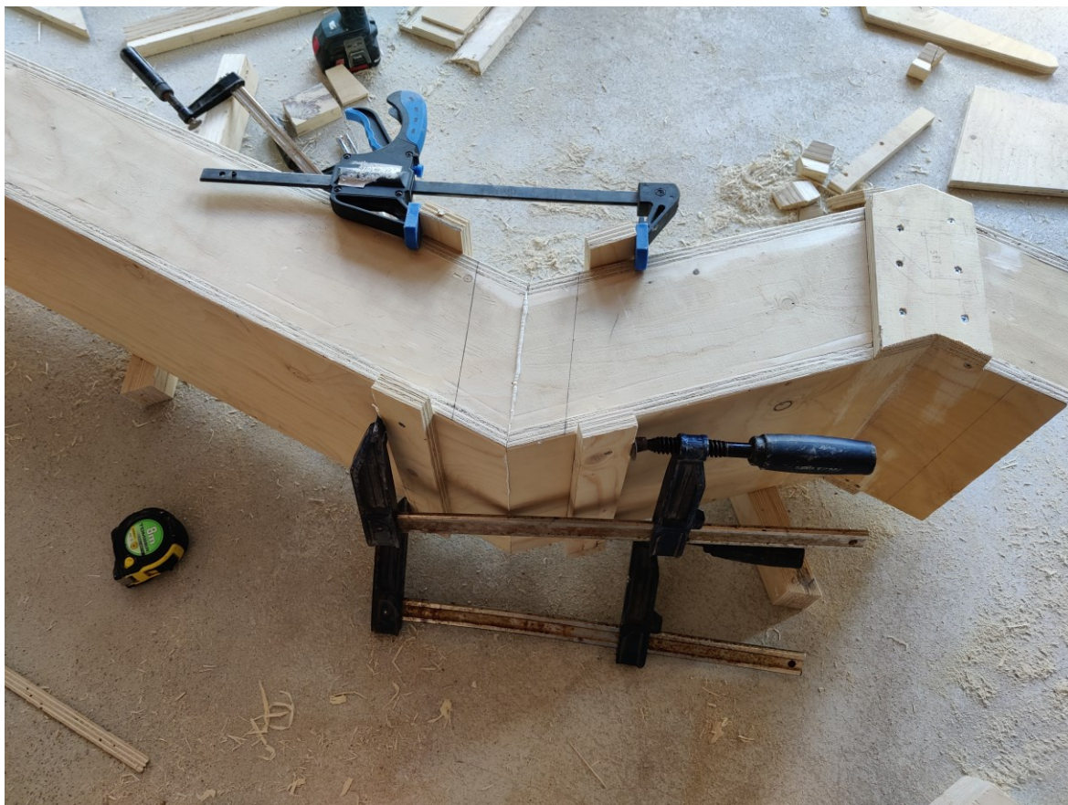
Kuva 17. Toisen makuuhuoneen poistoilmahormi, jossa on kaksi kulmaa (Pauli Parkkima)
