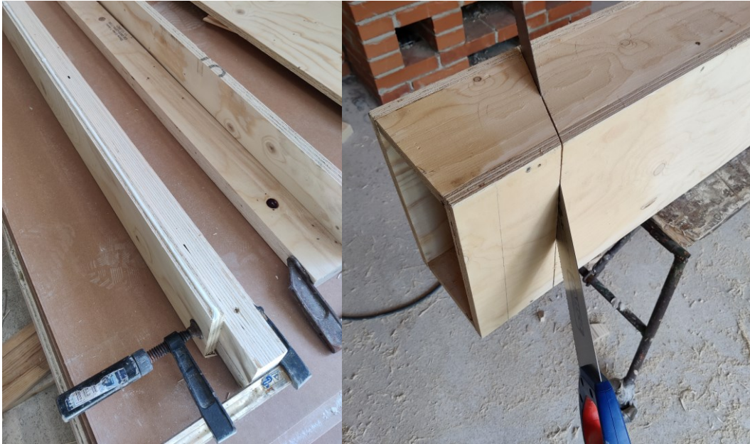
Kuva 15. Asennus jigi ja valmis kanava sekä sen sahaus (Pauli Parkkima)
