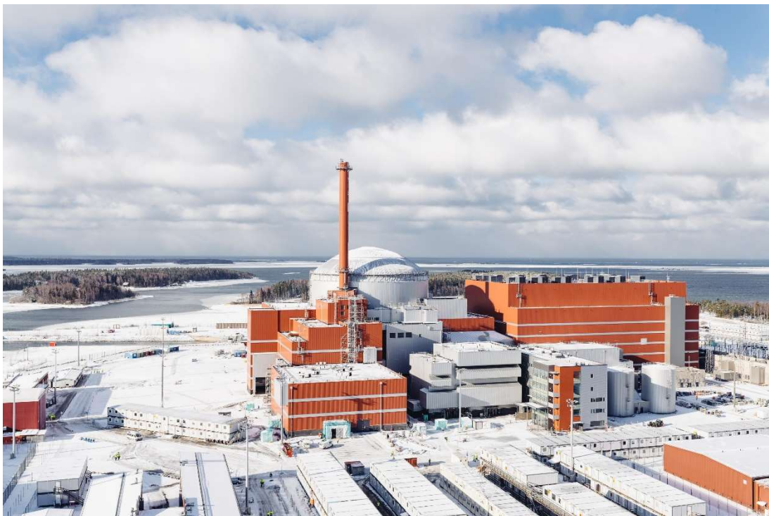
Kuva 1. Olkiluoto 3 -laitosyksikkö (Teollisuuden Voima Oyj, 2018)
