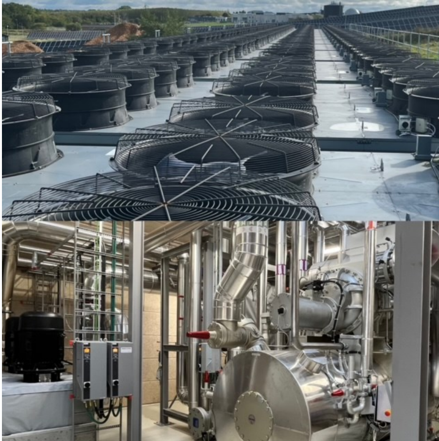
Kuva 14. IVLP-laitos Tanskassa, kylmäaine R717 (Mika Karbin).
