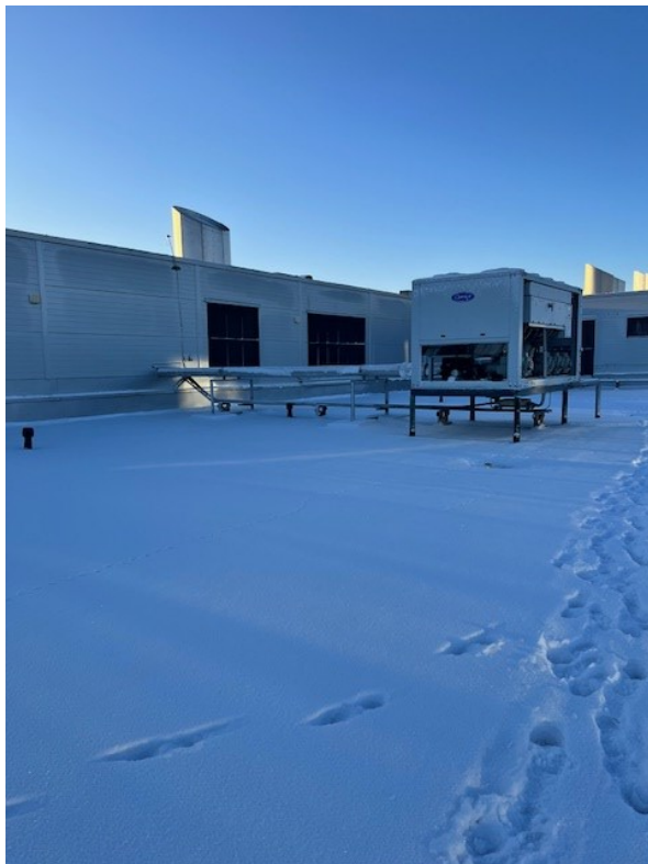
Kuva 8. Vedenjäähdytyskone vesikatolla (Mika Karbin).
